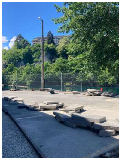
Des dalles ont été découpées lors du dégrappage
