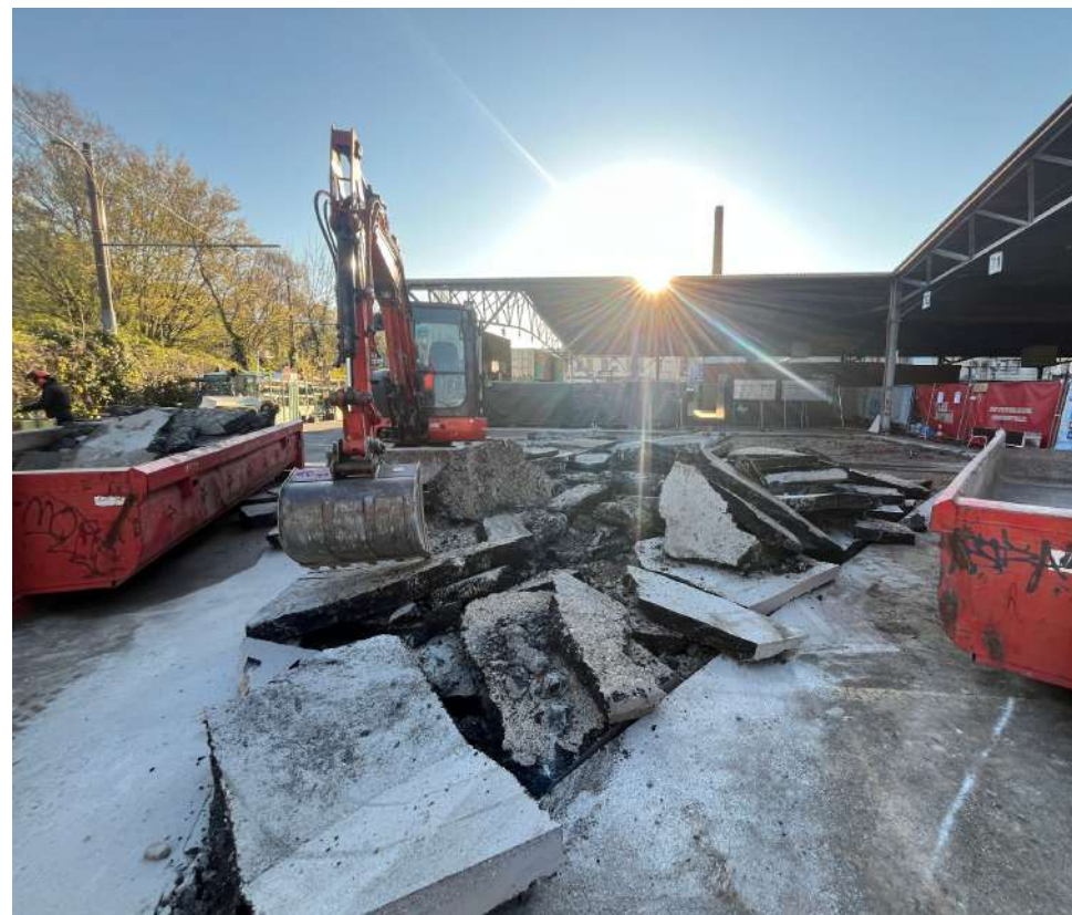
Dégrappage des espaces côté Rhône
